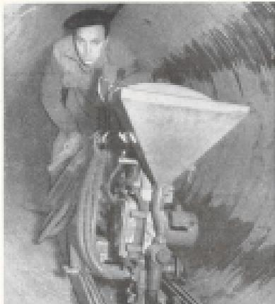
Solda senza alcun bagno collimatore di un collettore
