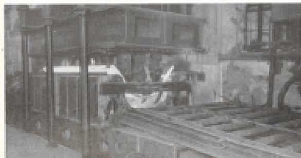
Una pressa da 100 T. stampa una lamina di 500 mm. di spessore
